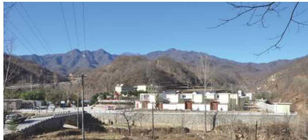
河南金牛搬迁尾矿库下游危险区居民
